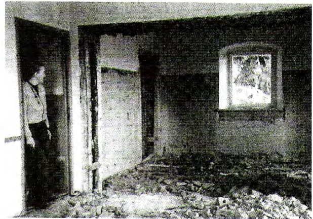
Hüttensanierung dritter Bauabschnitt (1981) Oben: Die Wirtin vor den Trümmern der Gaststube Unten: Neubau der Veranda
