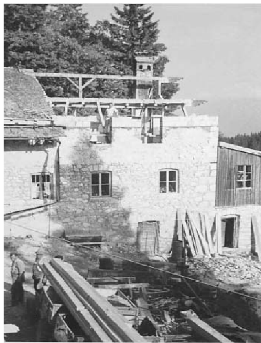
1970 Aufstockung des Brünsteinhauses
