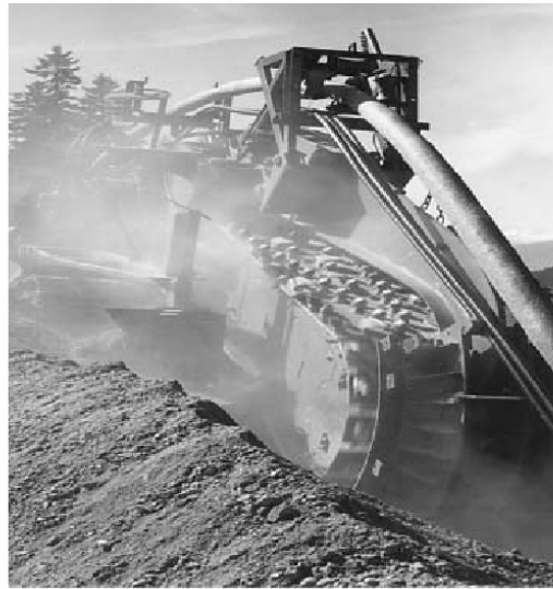
2002 Anschluss an öffentliche Strom- versorgung. Kabelgraben mit Strom, Telefon- und Abwasserleitung
