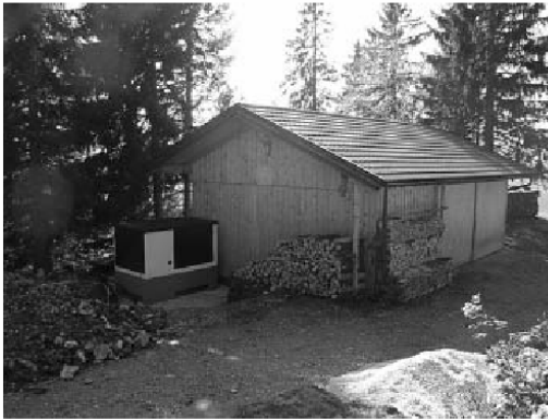
1994 Bau eines Gerätehauses, hier mit Trafostation
