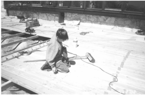
Der Bau der Terrasse nimmt Gestalt an
