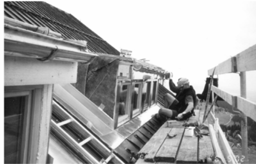
Arbeiten am Dach
