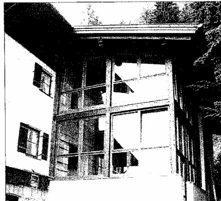
Trotz moderner Baumaterialien ist der Ostanbau rundum gelungen.
