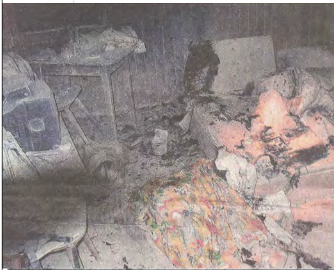
Total verwüstet: das Zimmer, in dem der Brand ausbrach. Foto: mv
