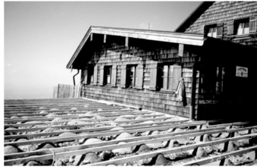
Der Untergrund der Hochriesterrasse
