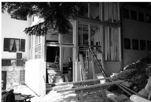
Die Fensterelemente sind gesetzt
