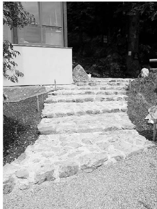
Auf der „Brunnsteinstiege“ zum Hauseingang
